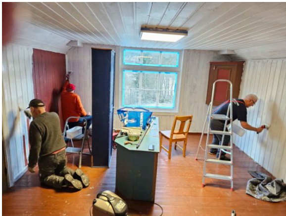
Figur 3 Oppussing på loftet i Ungdomshuset Foto Todalen.no gjengitt med tillatelse
