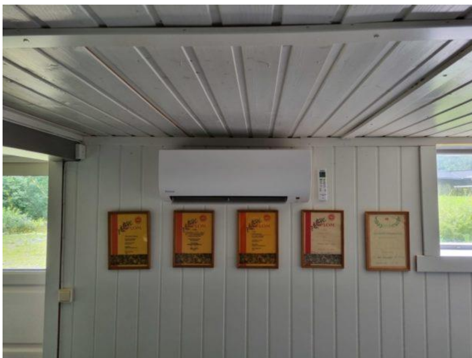
Figur 2 Varmepumpen i kjelleren. Denne besørger jevn og behagelig temperatur til en moderat kostnad. Foto: totalen.no gjengitt med tillatelse
