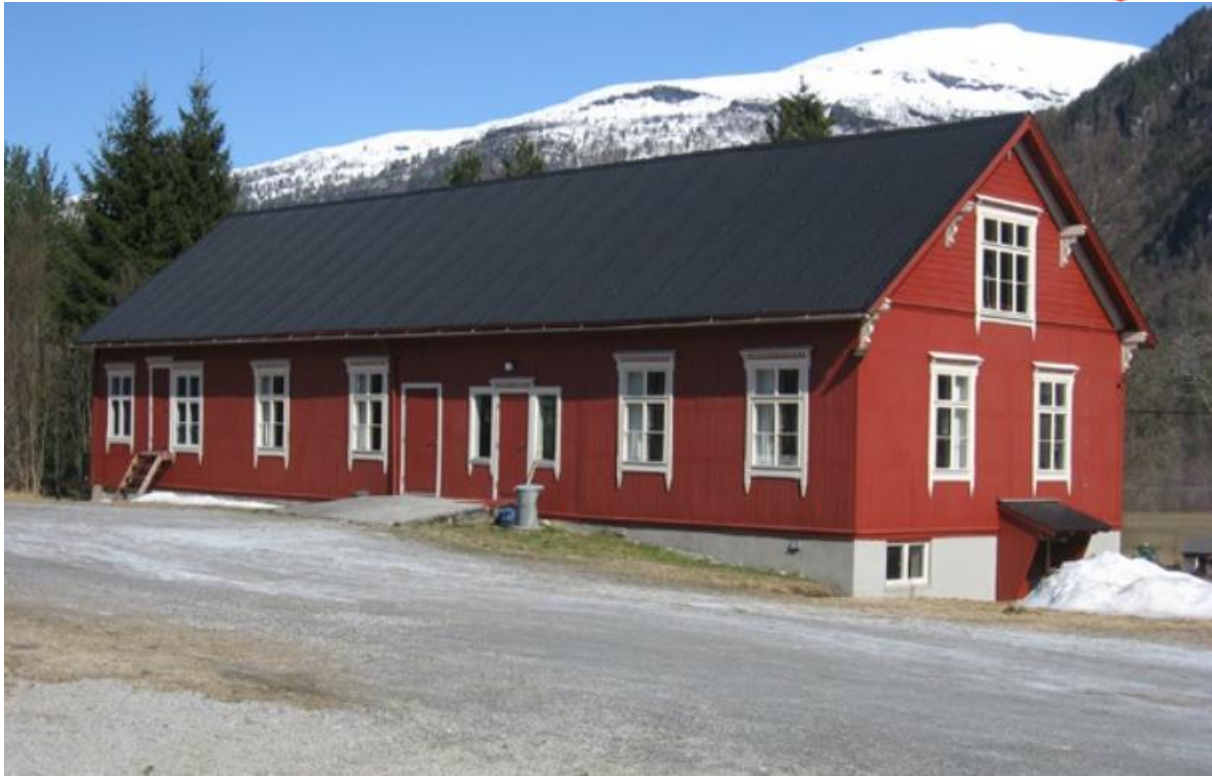
Figur 1 Ungdomshuset Foto: todalen.no gjengitt med tillatelse
