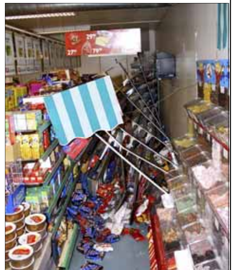
Butikkhyllene ramla ned frå vegg.
